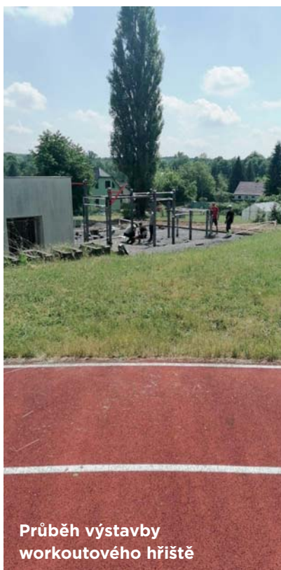
Vedení Michálkovic se zástupci zhotovitele na školním hřišti
