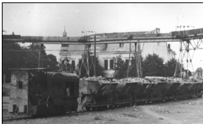
Vláček odvázející hlušinu na odval projížděl místem dnešní točny trolejbusů.
