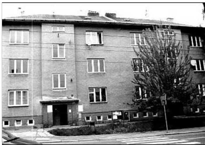
Nově získané bytové domy pro nájemní bydlení
