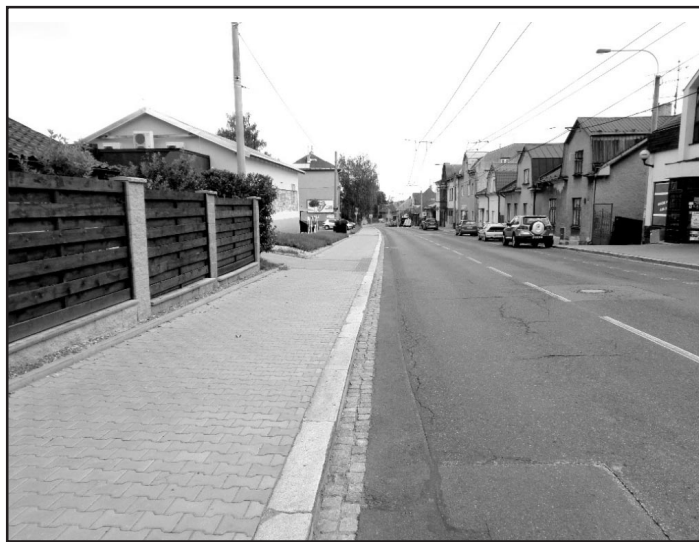
Opravené chodníky na ulici Československé armády
